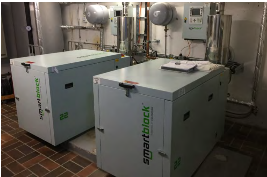
BHKW-Anlage mit 2x 22 kW(el)
