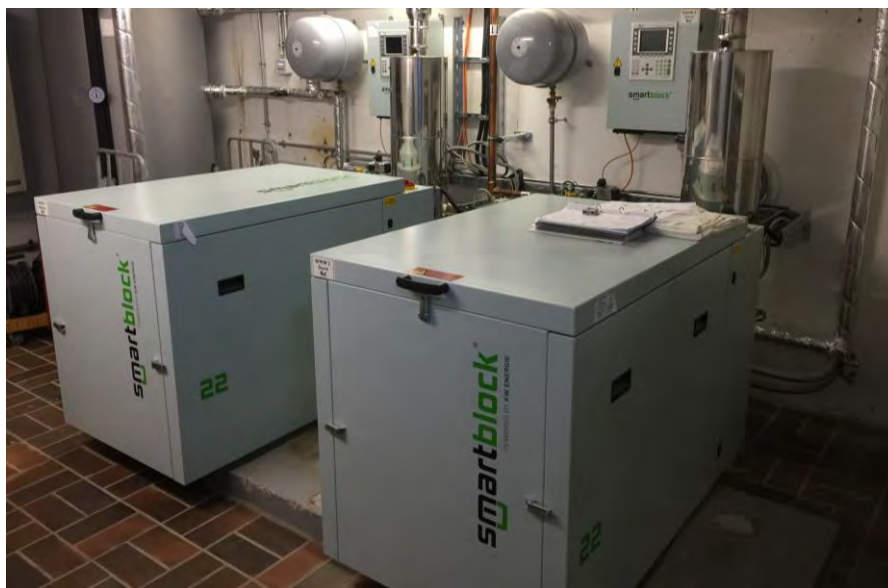
BHKW-Anlage mit 2x 22 kW el
