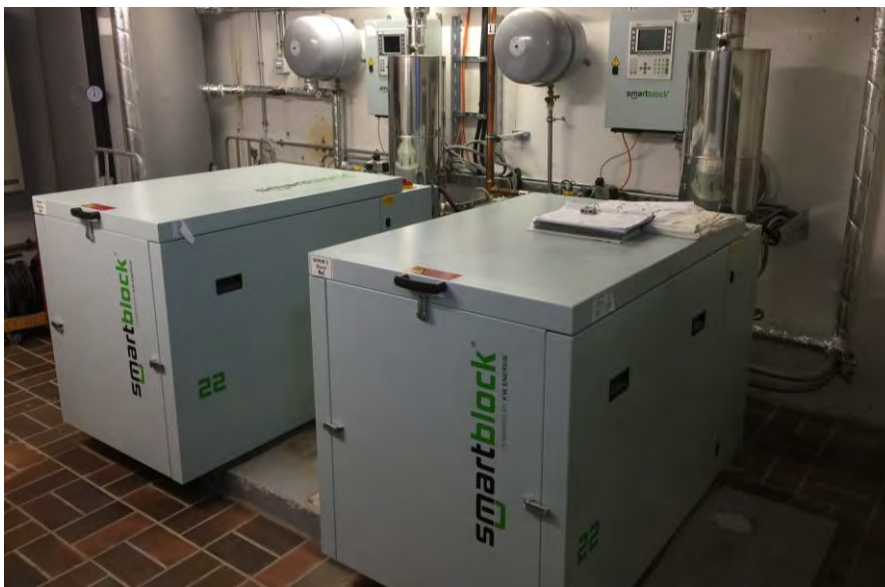
BHKW-Anlage mit 2x 22 kW el
